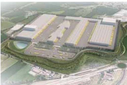
NELLA FOTO: la piantina del Polo Logistico di Esselunga a Ospitaletto
