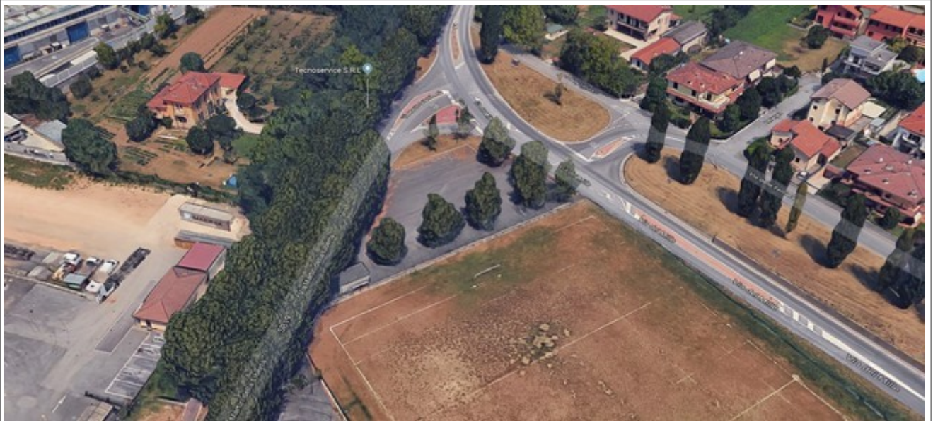
Vista aerea Area di attesa A5
