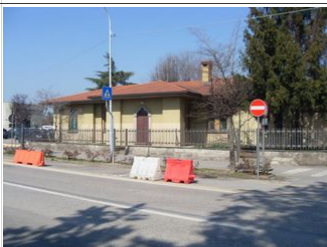
Foto 8 – Segreteria e spogliatoi tennis
