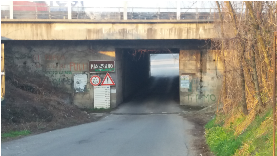
- Via Monte Grappa (sottopasso dell'autostrada A4)
